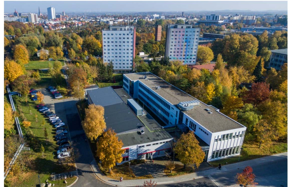
Technikum und Bürogebäude des Fraunhofer-Anwendungszentrums, Albert-Einstein-Straße 30
